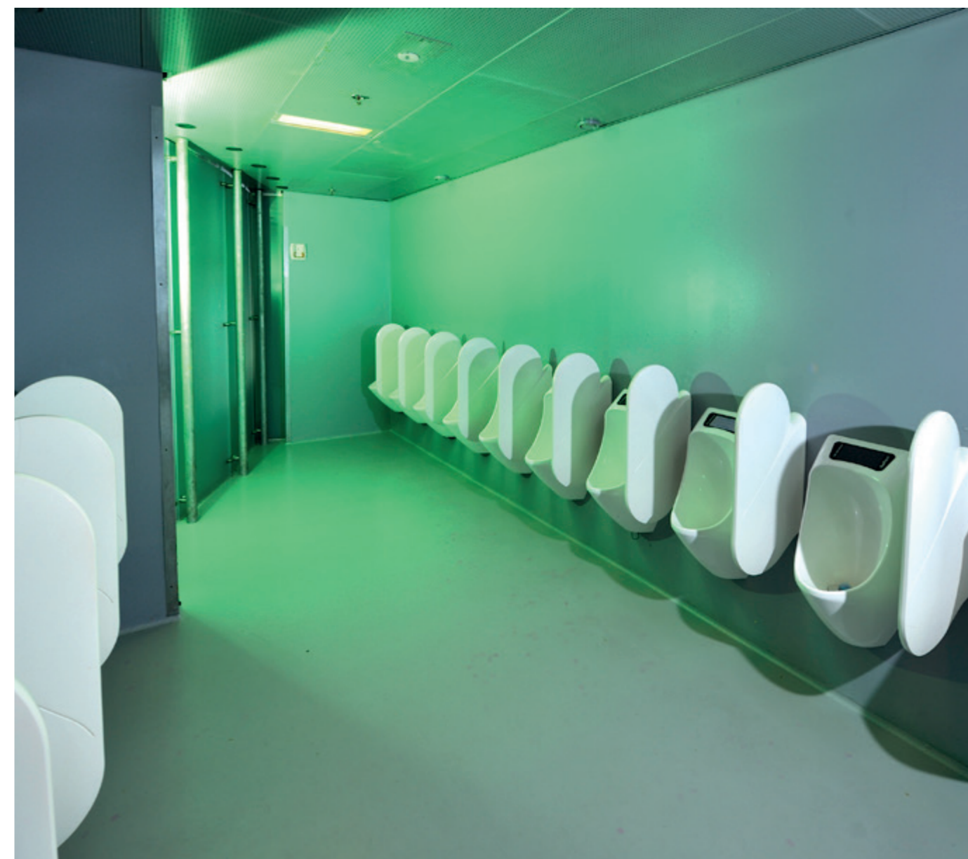
Urinoirs in AFAS Live (de voormalige Heineken Music Hall), fosfaatwinning uit afvalwater
