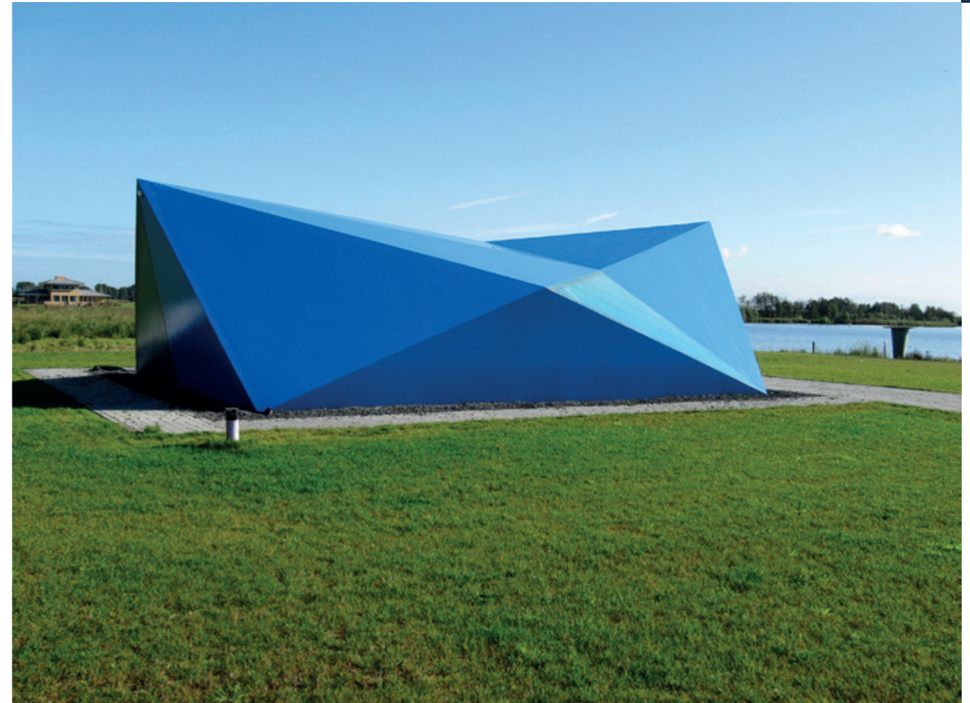
Koude Centrale Steenwijk: Koude uit een diepe zandwinplas voor het koelen van een bedrijventerrein
